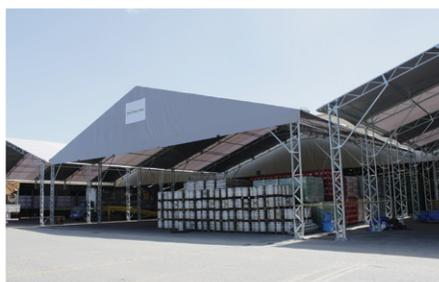
Fechamentos de cobertura, laterais e frontais feitos com lonas vinílicas de alta resistência, com propriedade auto-extinguível, com aditivação antimofa e antioxidante, desenvolvida para proporcionar maior durabilidade. Proteção blackout que impede a passagem de raios UV e IV. A intercalação de lonas translúcidas e lonas opacas no teto do galpão, permite maior incidência de luz natural proporcionando economia de energia elétrica. Durabilidade estimada de até 10 anos.
